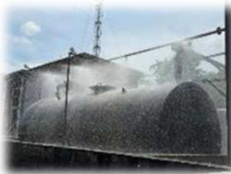
3.เปิดระบบดับเพลิง ด้วยโฟมผ่านท่อระบบ โฟมห้องปืม
