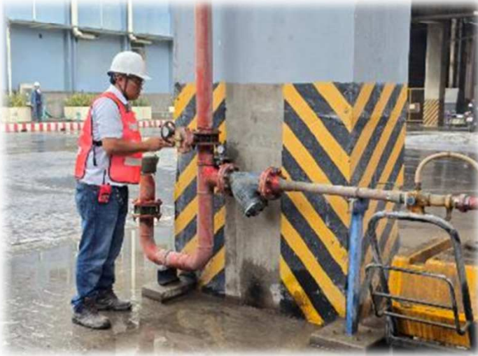
14.52น.ผช.สมบัติ สุขสำราญ (Shift ประจำกะ) นำทีม พนักงานทีมหม้อเผา นายเอก มุ่งดี และ นายวชิรศักดิ์ รุกขวิจารณ์ นำสายน้ำดับเพลิงต่อน้ำ Hydrant เข้าระบบ
